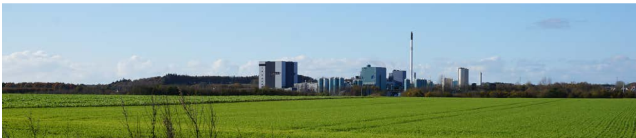
Landskabet påvirkes generelt af tekniske anlæg. Flere større industribygninger kan ses i store dele af landskabet. Her ses et større mejeri nær Videbæk.
