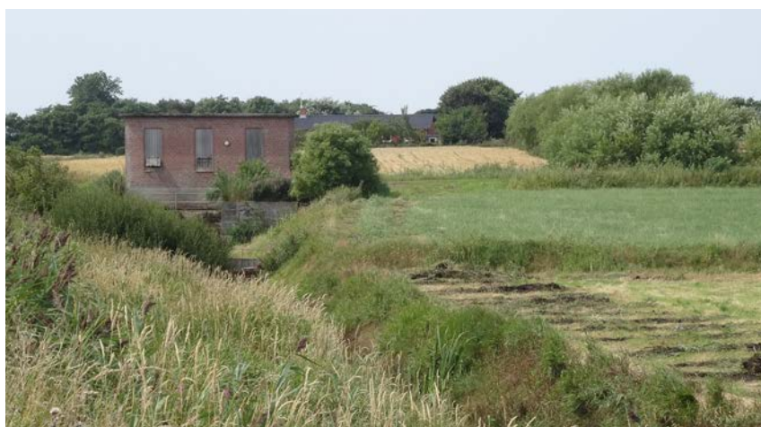
Pumpehuse er aktive flere steder i landskabsområdet og regulerer vandstanden i fjordlandskabet og de tilstødende lavbundsarealer. Her ses pumpehuset ved Spangvig Bro, der pumper vandet fra Madum Å's lavbundsområder.
